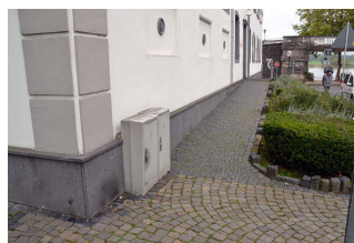
Rampe zum Eingang
