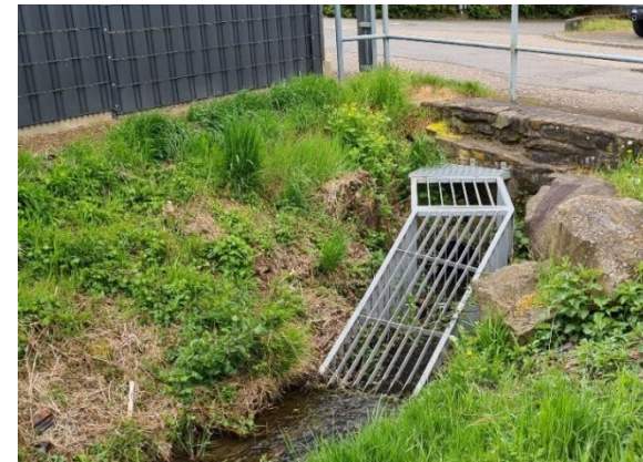
Einlaufbauwerk Auf'm Mühlenspitz (Heimbach-Weis)
