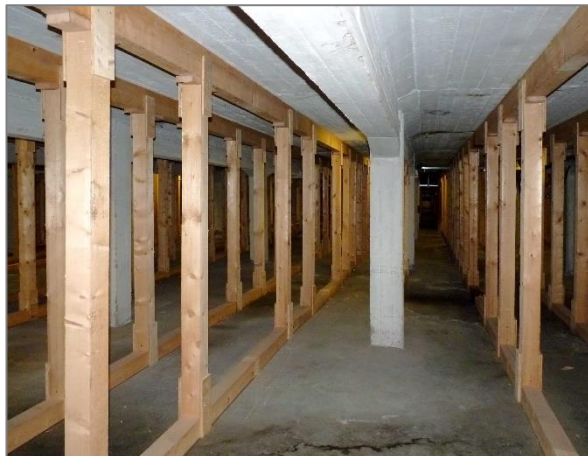
Abbildung 20: Blick in den außerordentlich weitläufigen südöstlichen Kellerraum der Halle 4.
