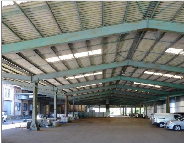
Abbildung 8: Halle 3, Blickrichtung Süden.
