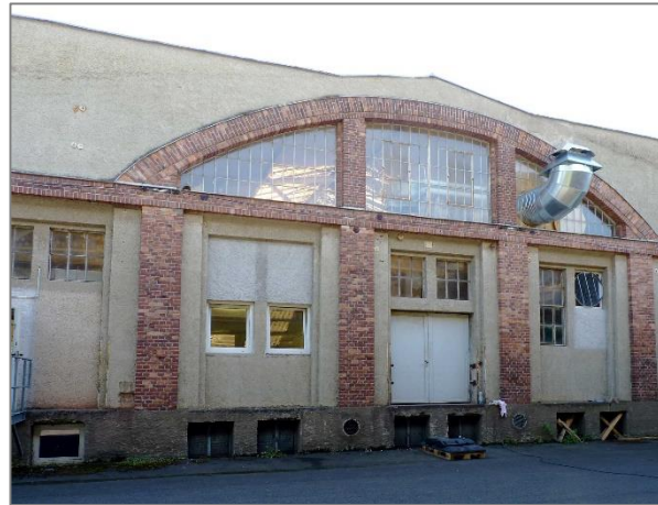
Abbildung 13: Gemauerter Fassadenabschnitt im südwestlichen Teil der Halle 4.
