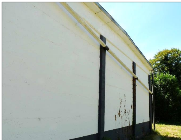
Abbildung 24: Westseite des Lokschuppens.
