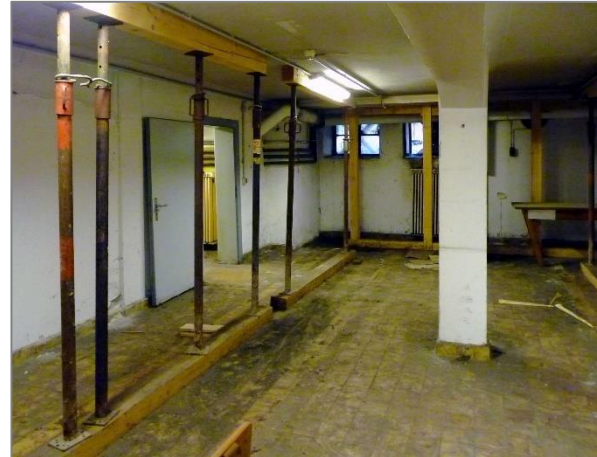
Abbildung 19: Ehemaliger Sanitärraum in der unterkellerten Halle 4.
