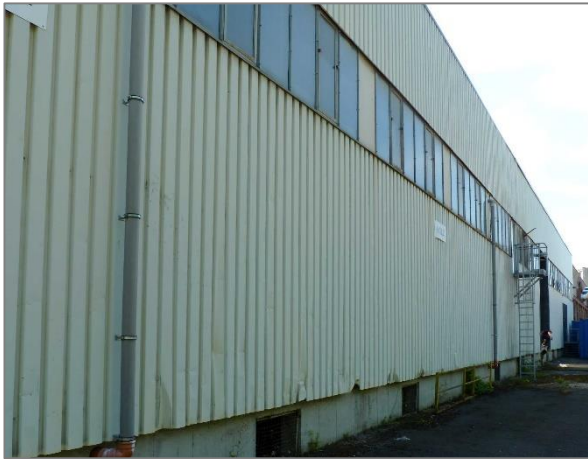
Abbildung 12: Fassade der Halle 4 im mittleren westlichen Teil.
