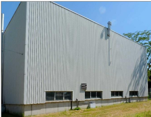
Abbildung 14: Südöstlicher Fassadenteil der Halle 4.
