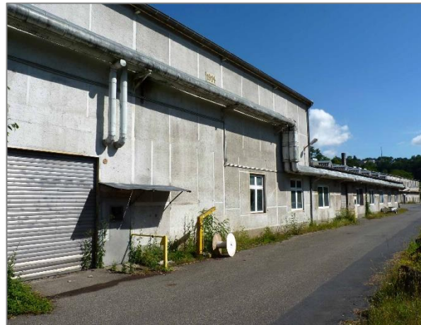
Abbildung 5: Die Fassade der Halle 13 weist keine nennenswerten Versteckstrukturen auf.
