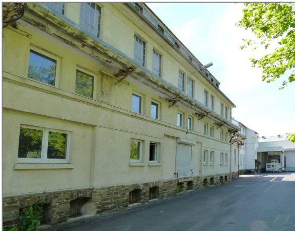
Abbildung 4: Am Gebäude Nr. 8 beschränken sich potenzielle Fledermaus-Verstecke auf den Dachbereich.
