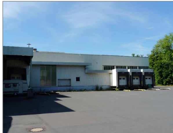
Abbildung 11: Nordwestseite der Halle 4.
