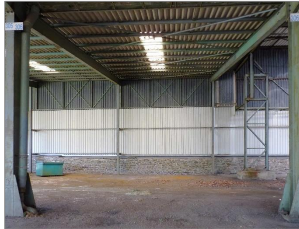
Abbildung 9: Halle 3, Blickrichtung Westen.
