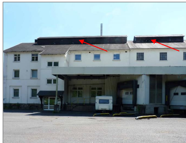
Abbildung 17: Nordwestende der Halle 4. Pfeile: mit Schindeln verkleidete Dachaufbauten.
