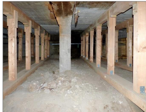
Abbildung 2114: Blick in den „Kriechkeller“ unter der Halle 4.
