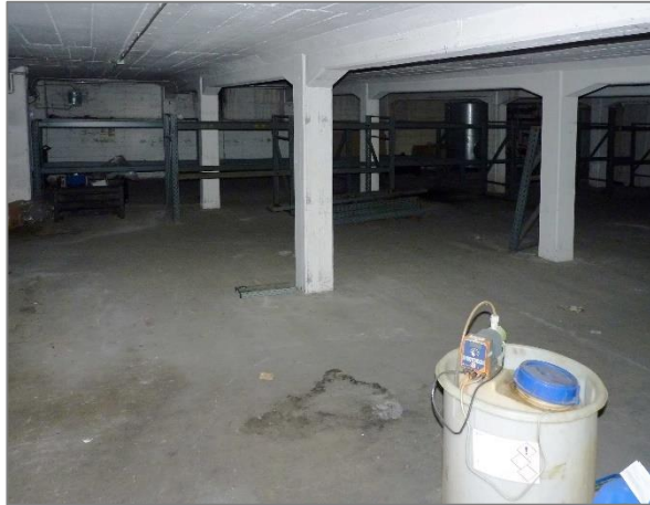
Abbildung 18: Blick durch die Öffnung des Kellerfensters (Abb. 15).
