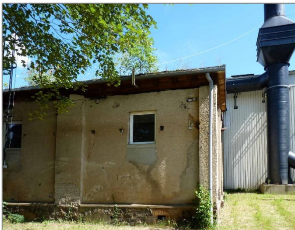
Abbildung 16: Gemauerter Anbau auf der Südseite von Halle 4.
