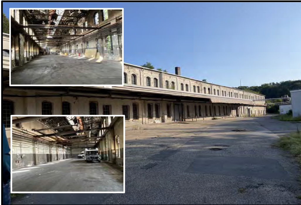
VF 7 - Alte Vergütere, Bereich der ehem.Temperei am nördlichen Ende der Halle.
