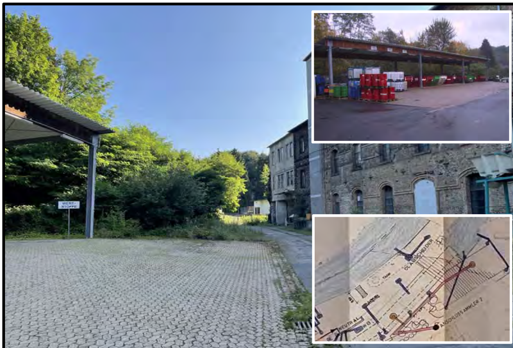
VF 6 - Ehemaliger Waschplatz mit Ölabscheider / Tank?, Lage des Ölabscheider und evtl. ehemals vorhandenem Tank vgl. kleiner Lageplan Entwässerung [26].
