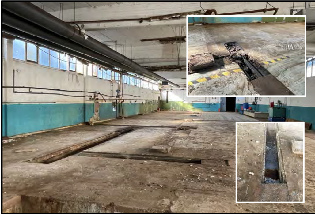
VF 1 - Galvanikhalle, Standorte der Chromatier, Phosphatier- und Verzinkungsbecken mit Ableitungsschächten und Rohren in Richtung Abwasserbehandlung.
