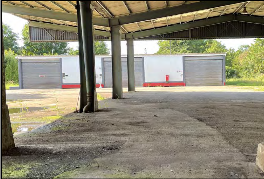
VF 17 - Lokschuppen / Gefahrstofflager / ehem. Dieseltankstelle Stapler
