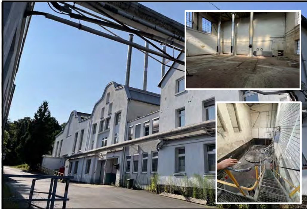
VF 15 - Kesselhaus mit Feuerungsstellen und ehem. Lagerraum für 3 x 125 m 3 Heizöltanks.
