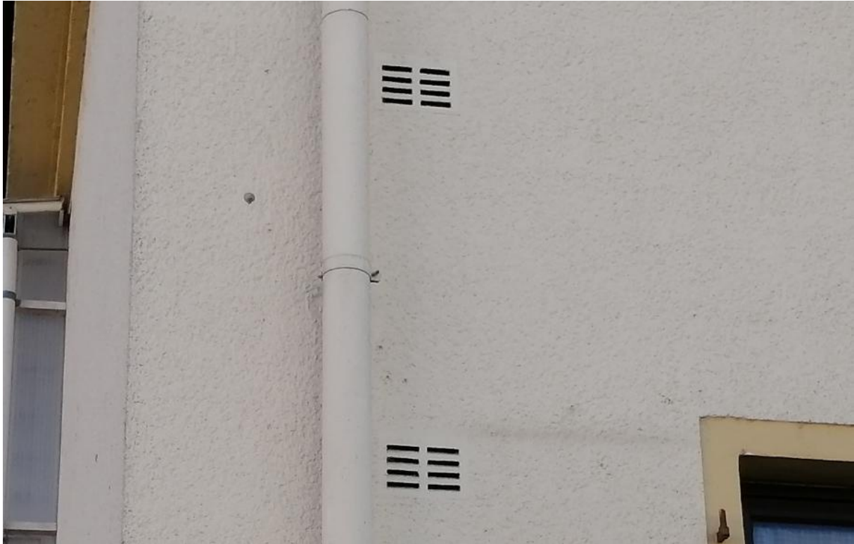
Abb. 8: Belüftungsschächte an Gebäuden im Plangebiet als potenzielle Quartiere für Fledermäuse
