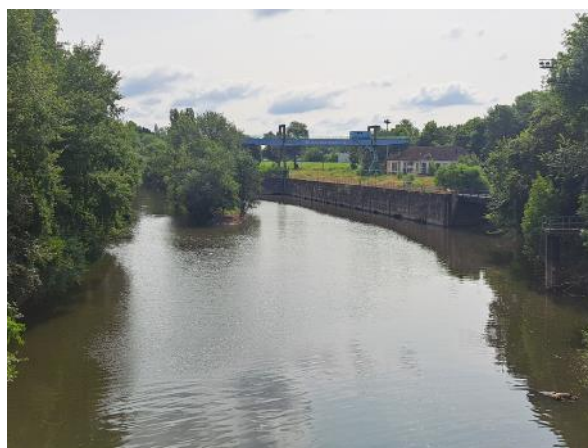
Abb. 5: Bestandssituation Hafenkran, Juli 2024, (Quelle: eigene Aufnahme)
