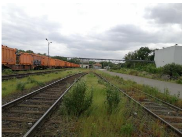
Abb. 4: Bestandssituation Gleisanlage, Mai 2023, (Quelle: eigene Aufnahme)
