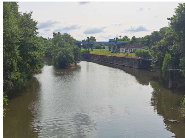
Abbildung 17: Bestandssituation Hafenkran, Juli 2024, (Quelle: eigene Aufnahme)
