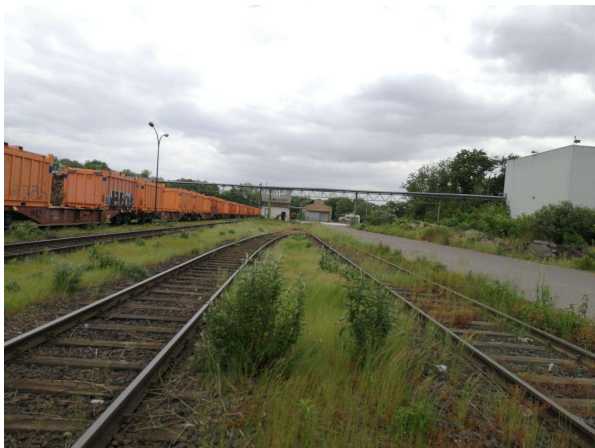
Abbildung 16: Bestandssituation Gleisanlage, Mai 2023, (Quelle: eigene Aufnahme)
