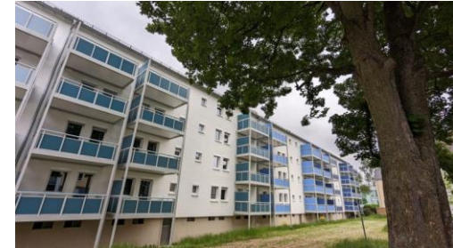
Energetische Sanierung mit öffentlicher Förderung © GSG-Neuwied
