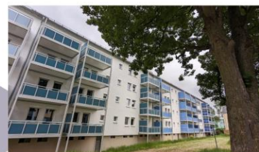
Energetische Sanierung mit öffentlicher Förderung © GSG-Neuwied
